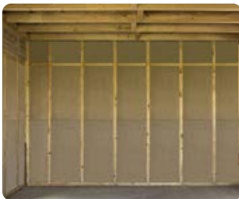
*ITI entre ossature bois en panneaux de fibre de bois*
