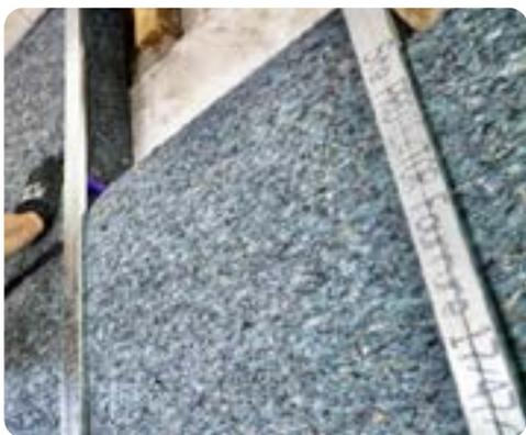
*ITI entre ossature métallique en panneaux de laine de coton*
